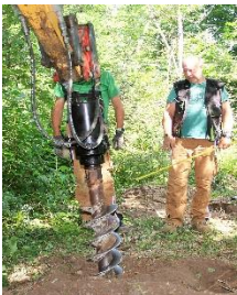
unten: Bauarbeiten mit schwerer Technik
